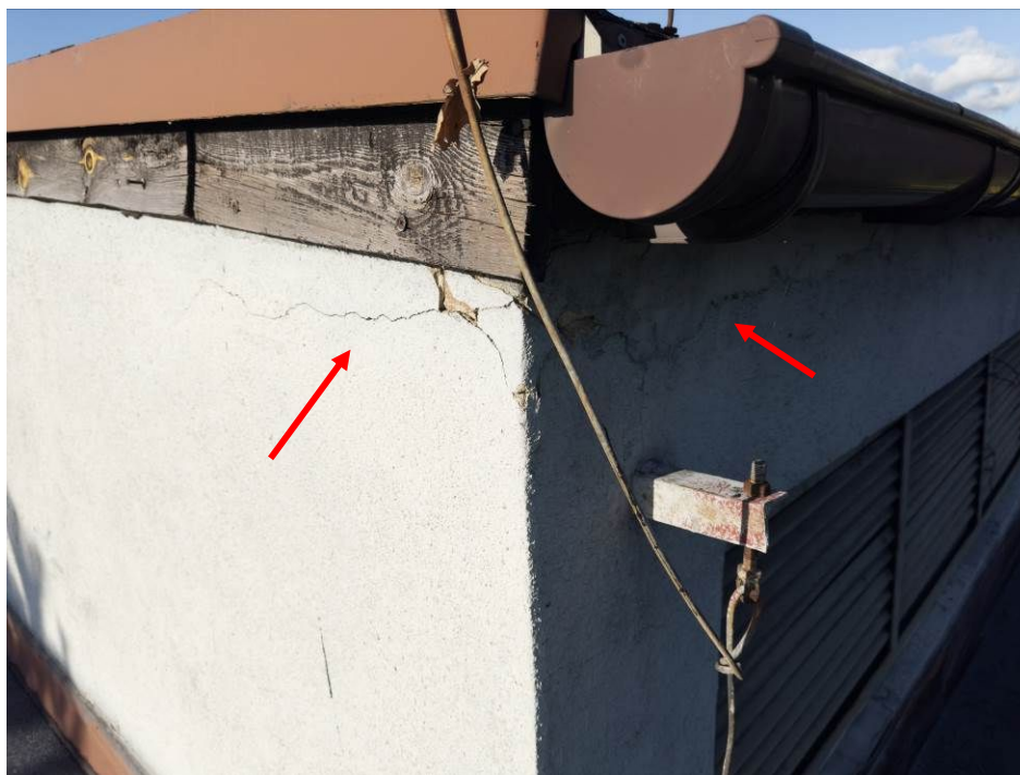
Fot.6 Uszkodzenia narożnika południowo-wschodniego stropodachu nad komorą trafo, [4].
