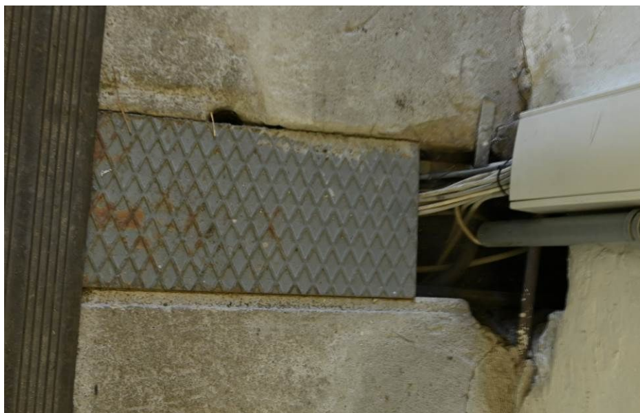
Fot.29 Fragment kanału – widoczne uszkodzenia korozyjne okuć i blachy, [4].
