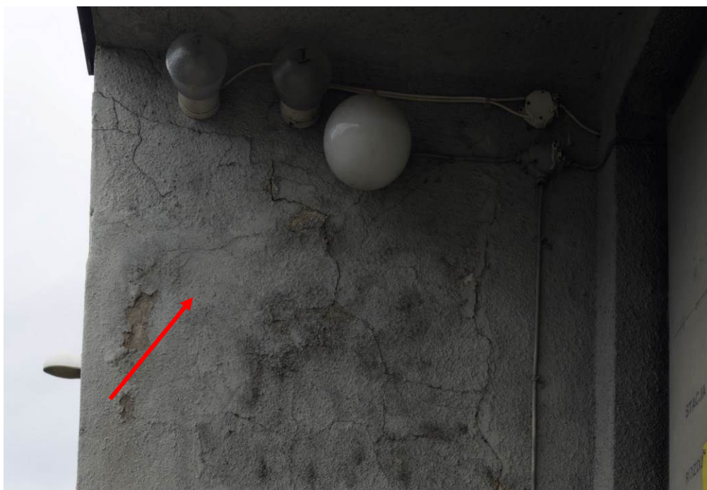
Fot.3 Zarysowanie ścianki, [4].
