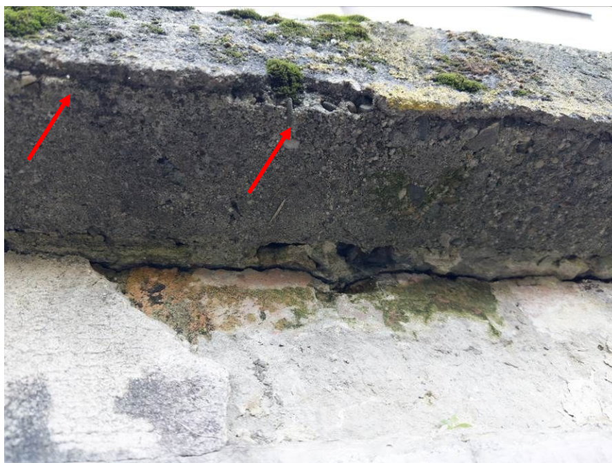
Fot.20 Płyta rampy, widoczne uszkodzenia płyty żelbetowej -ubytki betonu, odsłonięte pręty zbrojenia płyty, [4].
