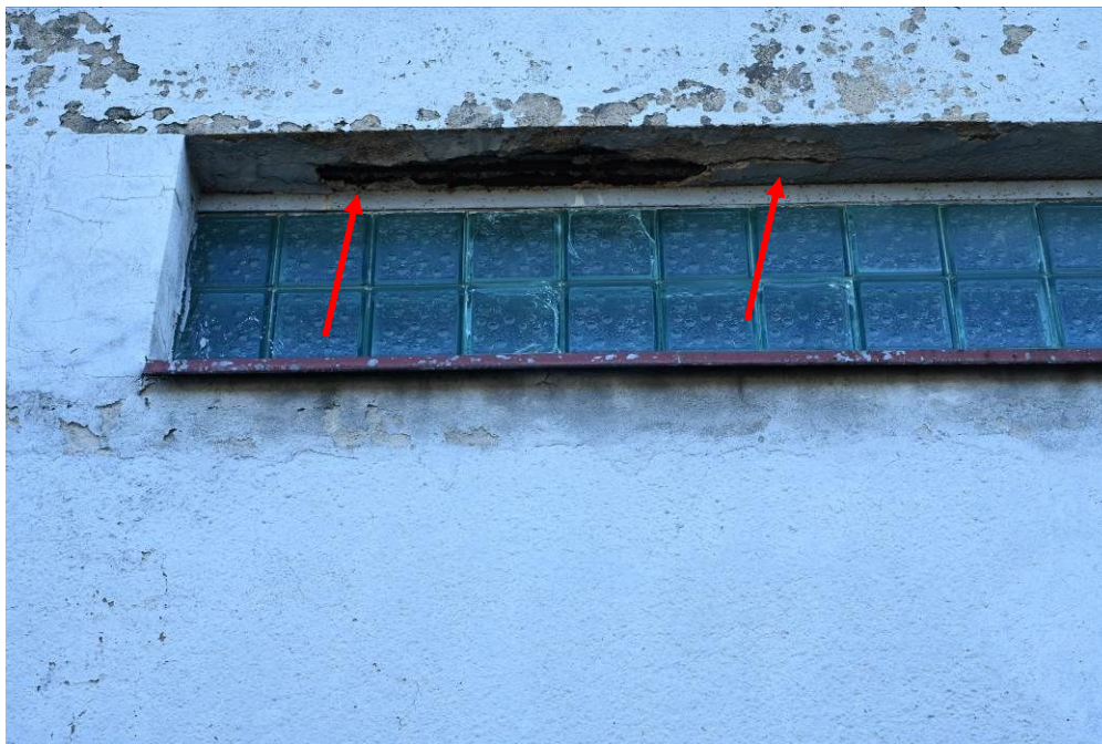
Fot.4 Uszkodzenia korozyjne nadproża okiennego komory trafo, widok od zewnątrz, [4].
