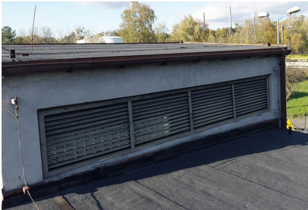
Fot.7 Nadproże otworu nad żaluzjami wywiewnymi komory trafo, widok od zewnątrz, brak uszkodzeń, [4].
