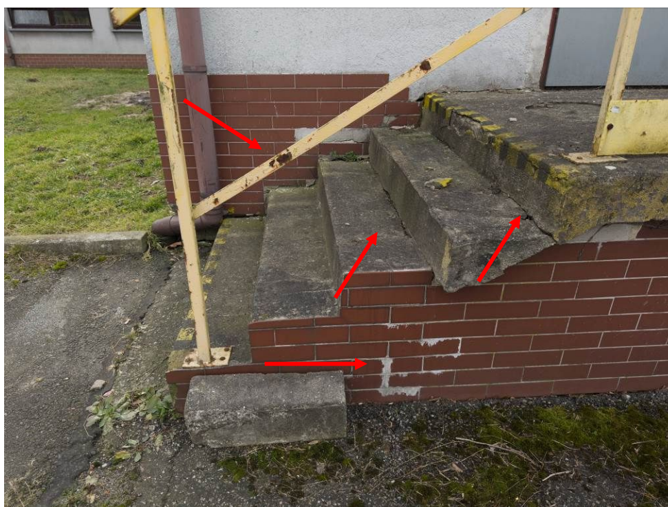
Fot.18 Schody na rampę – widoczne uszkodzenia stopni, ścianki oraz okładziny elewacyjnej, [4].
