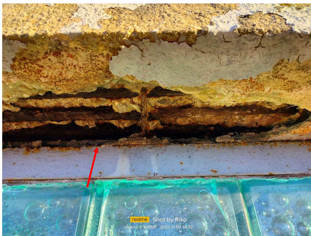
Fot.5 Uszkodzenia korozyjne nadproża okiennego komory trafo, [4].
