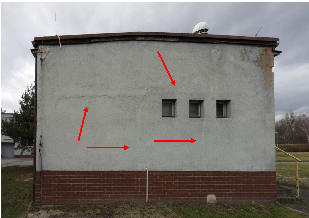
Fot.10 Ściana wschodnia obiektu, widoczne - ślady napraw i rysa pionowa [4].
