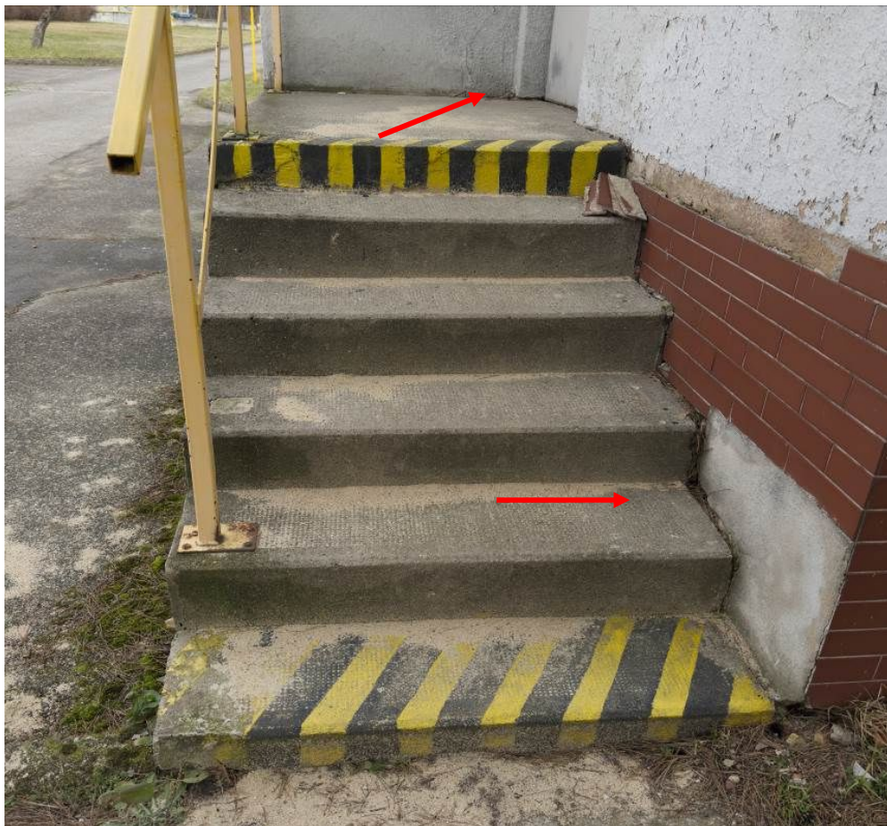
Fot.15 Zewnętrzna klatka schodowa - widoczny przechył w kierunku zachodnim, [4].
