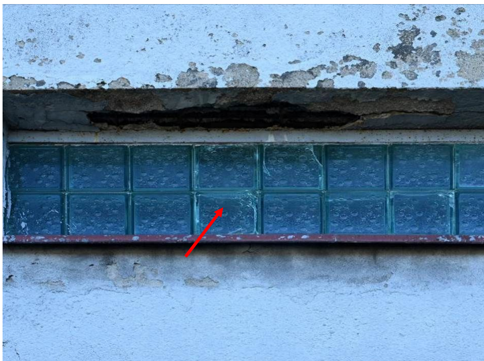
Fot.1 Elewacja zachodnia – uszkodzone pustaki szklane na skutek nacisku uszkodzonym nadprożem, [4].
