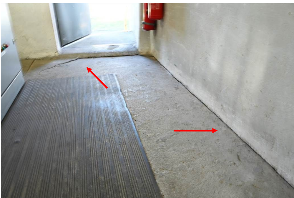
Fot.13 Wnętrze rozdzielni – widoczne osiadanie fragmentu posadzki, [4].
