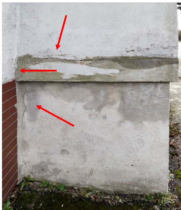
Fot.17 Zewnętrzna klatka schodowa – zarysowania ścianki ograniczającej podest, [4].
