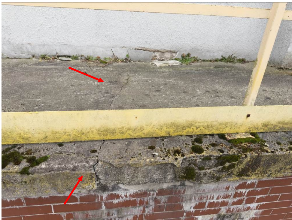
Fot.21 Płyta rampy - widoczne pęknięcie płyty, [4].
