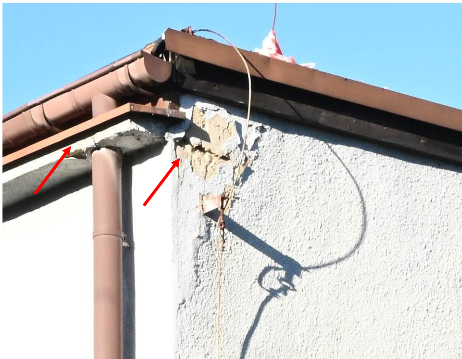
Fot.4 Uszkodzenia narożnika południowo-wschodniego, [4].
