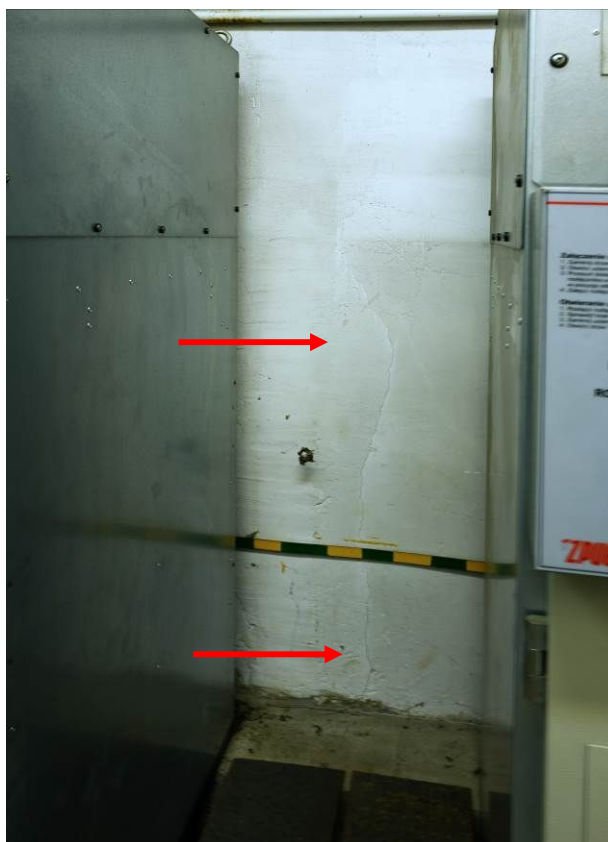
Fot.12 Ściana wschodnia obiektu, widok od wewnątrz - widoczne ślady napraw i zarysowanie wtórne rysy pionowej przy posadzce, [4].
