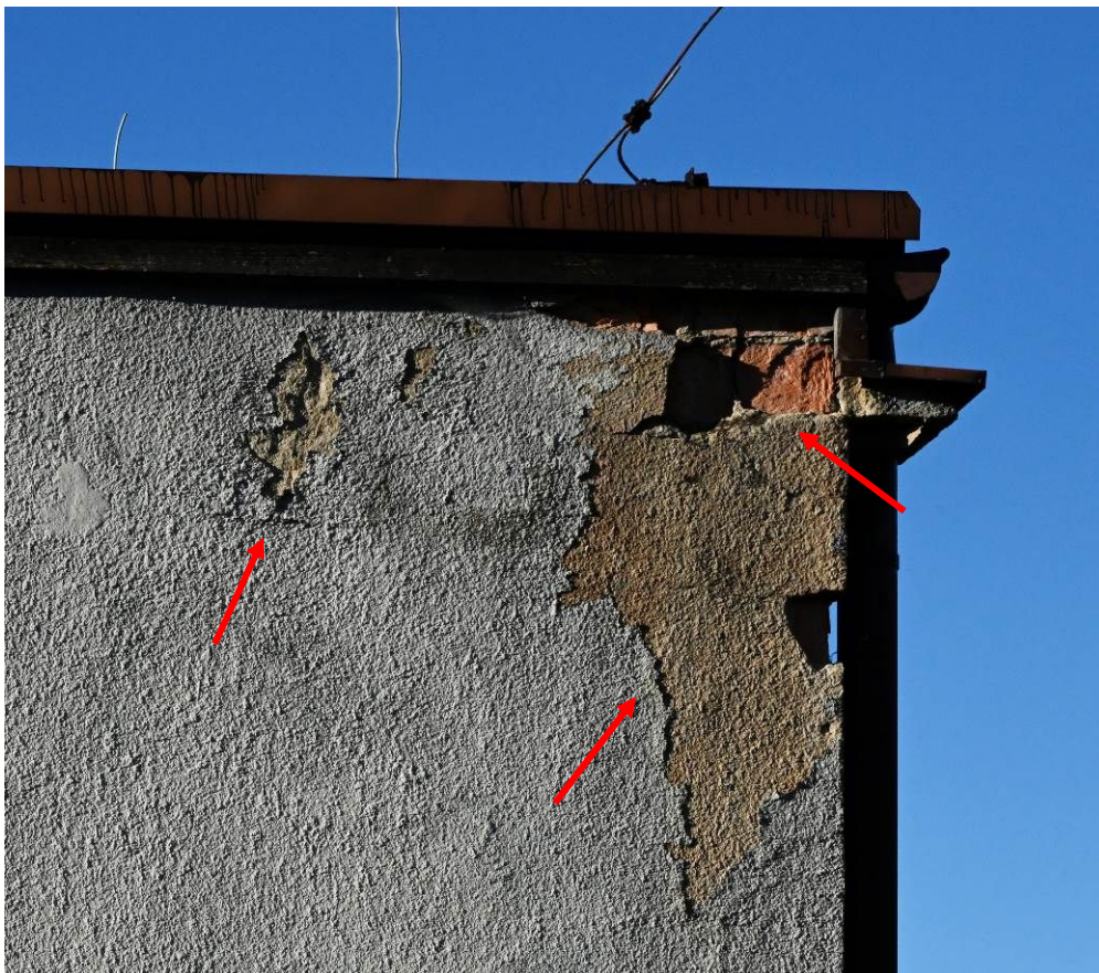
Fot.26 Elewacja wschodnia – widoczne lokalne ubytki farby i tynku, miejscowe lasowanie się cegły, [4].
