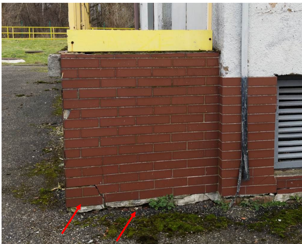
Fot.22 Ściana boczna rampy, widoczne uszkodzenia ściany na skutek nierównomiernego osiadania – zarysowania ukośne ściany, [4].
