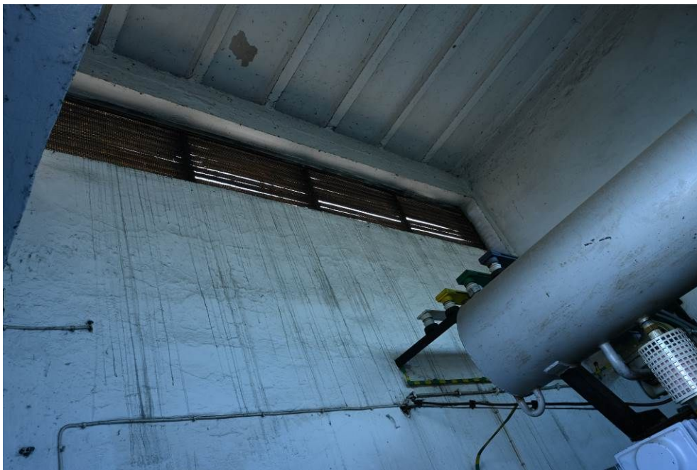
Fot.8 Nadproże otworu nad żaluzjami wywiewnymi komory trafo, widok od zewnątrz, brak uszkodzeń, [4].
