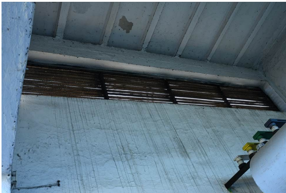
Fot.30 Fragment żaluzji wywiewnych – widoczne uszkodzenia korozyjne, [4].
