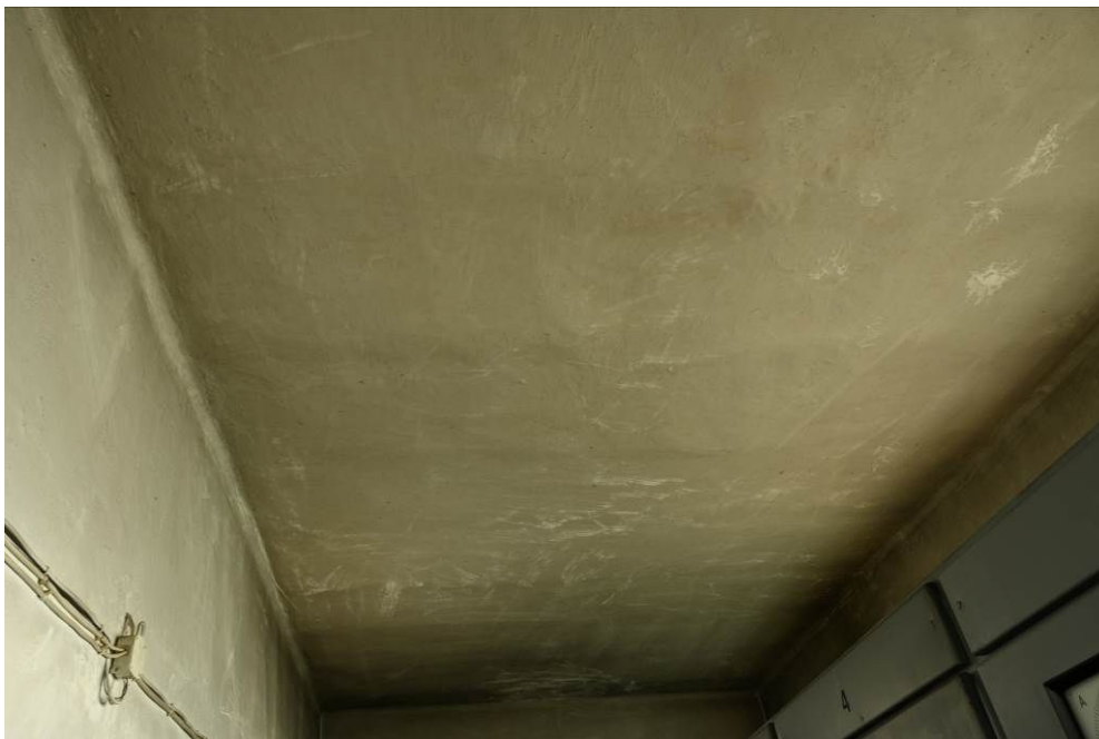
Fot.24 Pomieszczenie rozdzielni – widoczne zabrudzenia ściany, lokalne odspojenia farby, [4].
