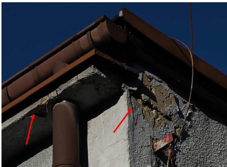
Fot.5 Uszkodzenia narożnika południowo-wschodniego, widoczne ścięcie cegły oraz wysunięcie z lica ściany, a także uszkodzenie płyty żelbetowej gzymsu, [4].
