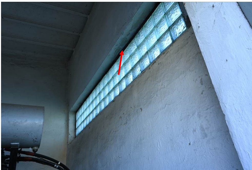
Fot.6 Uszkodzenia korozyjne nadproża okiennego komory trafo, widok od zewnątrz, [4].
