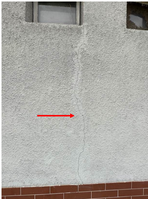
Fot.11 Ściana wschodnia obiektu, widoczne zarysowanie wtórne rysy pionowej, [4].
