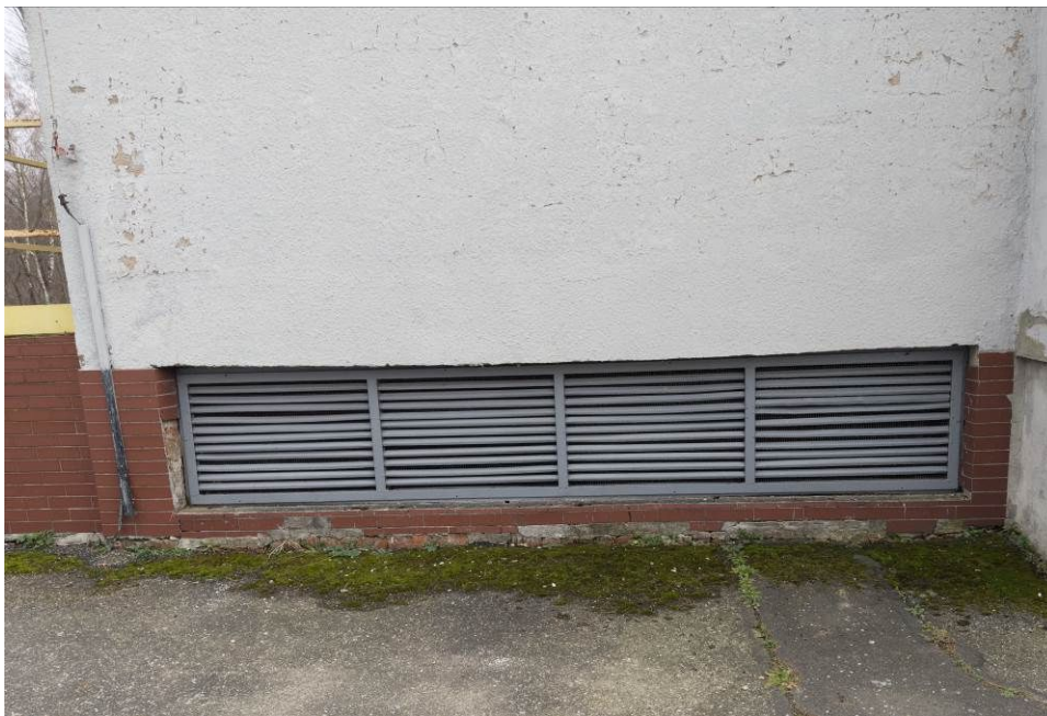
Fot.9 Nadproże otworu nad żaluzjami wywiewnymi komory trafo, widok od zewnątrz, brak uszkodzeń, [4].
