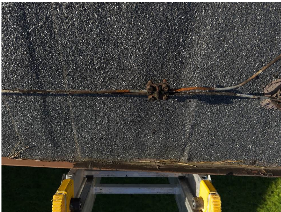
Fot.28 Fragment instalacji odgromowej – widoczne uszkodzenia korozyjne, [4].
