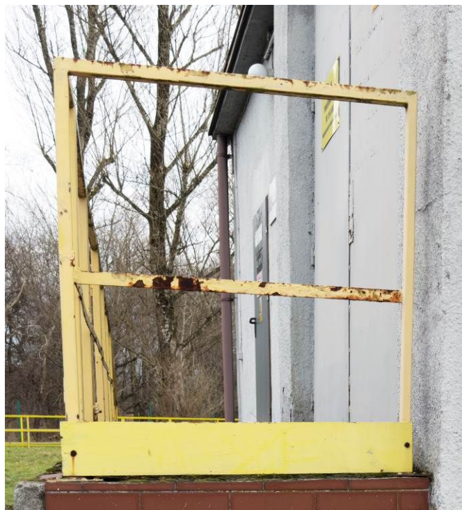
Fot.27 Barierki rampy – widoczne uszkodzenia korozyjne, [4].
