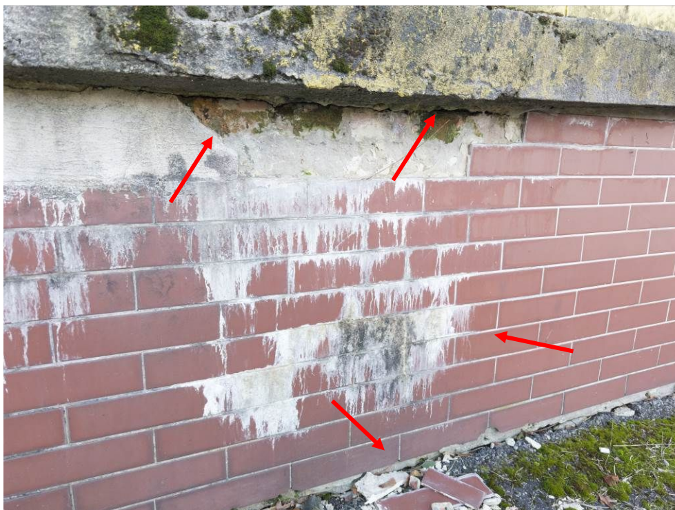
Fot.23 Ściana podłużna rampy, widoczne zacieki z rozpuszczalnych związków wapnia, odspojenia płytek, ubytki tynku, rysa pozioma pod płytą, [4].
