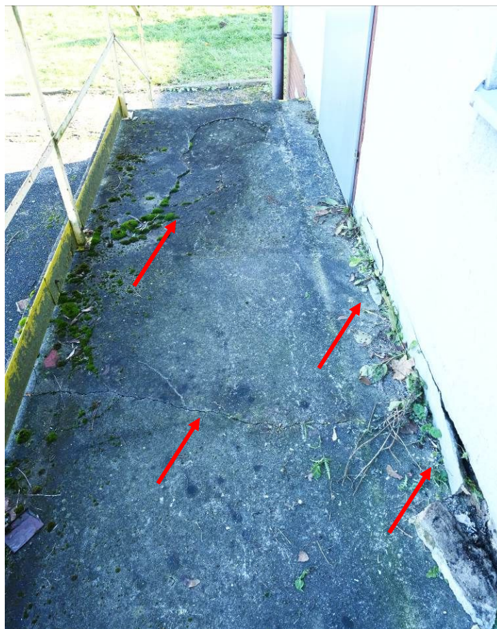
Fot.19 Płyta rampy – widoczne uszkodzenia nawierzchni, zarysowania, odspojenia szlichty, korozję biologiczną, [4].
